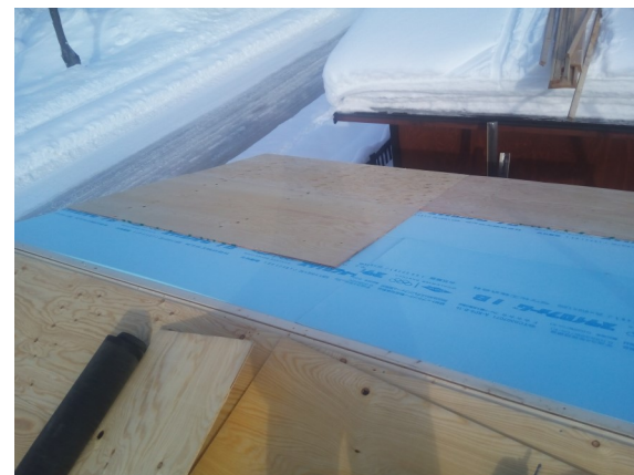
下地の野地板と同様に、2枚目の野地板を取り付けます。
