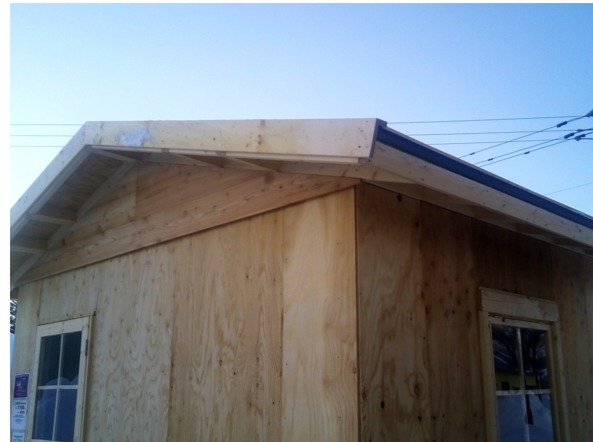
水切り、防水シート、屋根材を取り付けて、最後に破風板を取り付けます。
