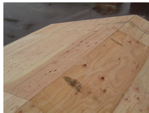
屋根材取付用定規を使用し、垂木位置を確認しステンスリムコーススレット65mmで野地板を固定します。
