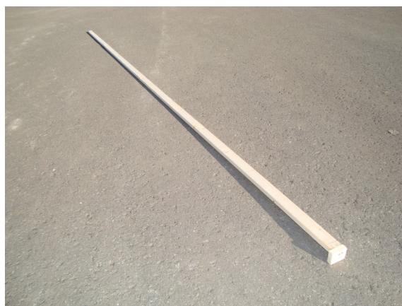
屋根材取付用定規を使用し、垂木位置を確認しステンスリム65mmで野地板を固定します。
