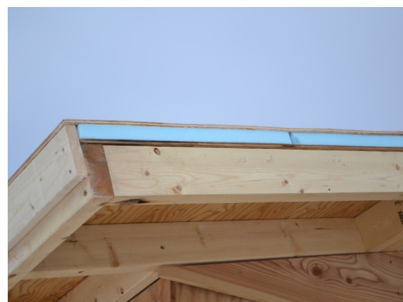
断熱材を貼った後に野地板を貼った状態
