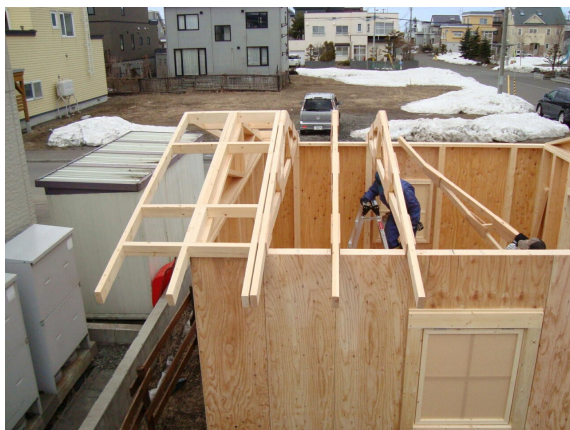
トラスは455mmピッチ(壁パネルの半分)で取付ます。墨つけを。
