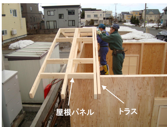
トラスを屋根パネルに取り付けます。
